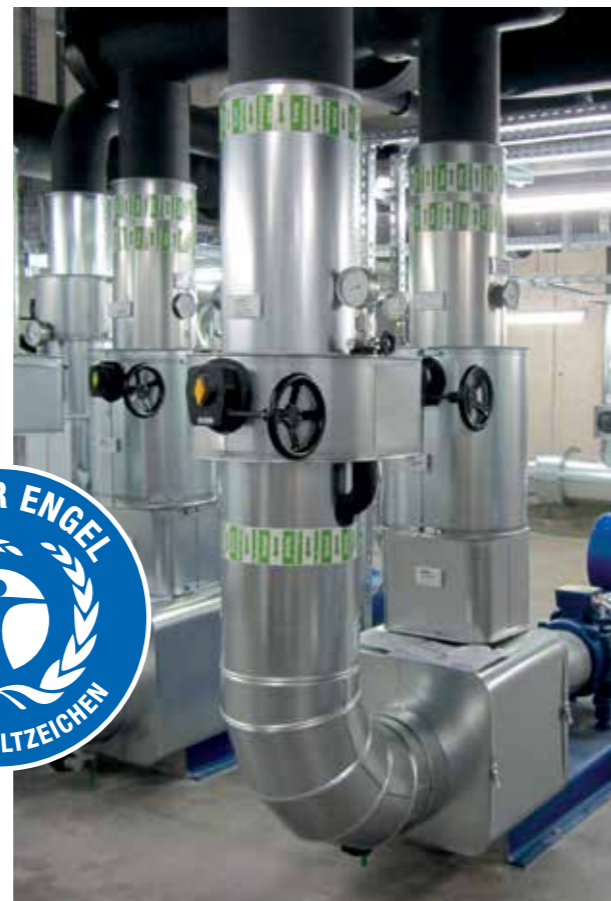
Die vom Supercomputer Hawk erzeugte Wärme wird zur Beheizung der Gebäude genutzt und die eingesetzte freie Kühlung benötigt deutlich weniger Energie als herkömmliche in Rechenzentren genutzte Klimaanlage.
